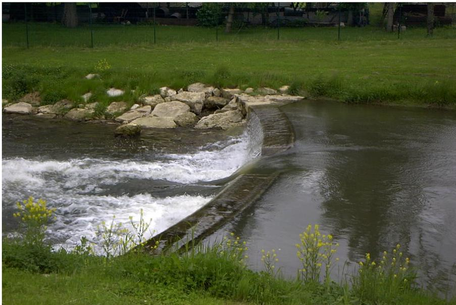
*Figure 6. Aménagement d'un barrage sur le bassin versant de l'Oise Amont. Mise en place d'un seuil pour lutter contre l'érosion régressive et aménagement des berges par techniques mixtes (enrochement et génie végétal ; SIABOA, 2003)*
