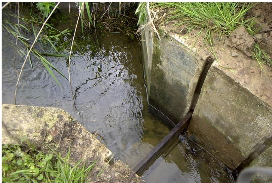
Figure 8. Système de seuil amovible en vue de permettre le maintien de la submersion d'une « frayère à brochet » sur le bassin versant de l'Oise Amont (SIABOA, 2004)
