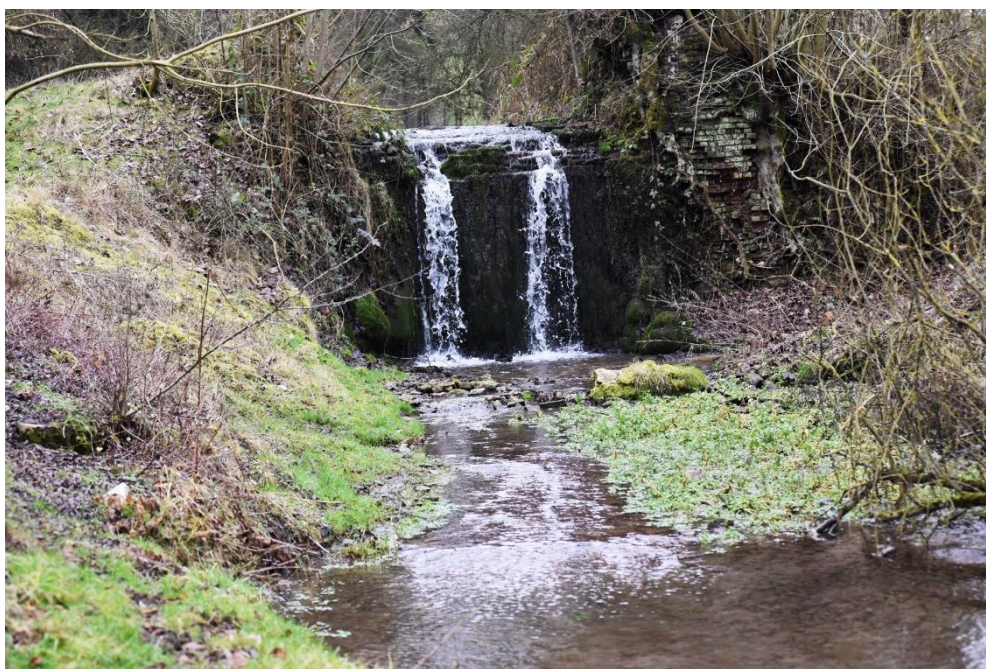
Figure 45 : Barrage sur la Selle à Saint-Martin-Rivière (source : JM. Szczyt)
