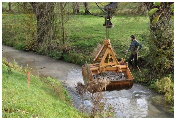
Figure 16 : Travaux de recharge granulométrique
