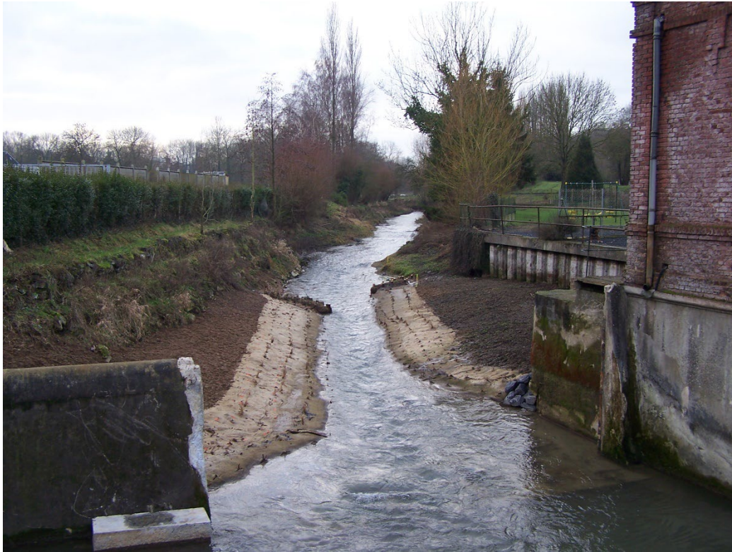
Figure 3 Aménagement de l'ouvrage du Pont Fourneau à Le Cateau en 2010 (SMBVS)
