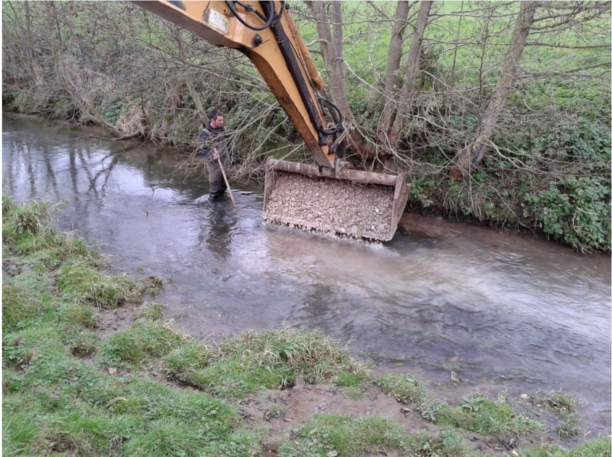
Figure 15 Recharge granulométrique à Saint Benin (FD59)
