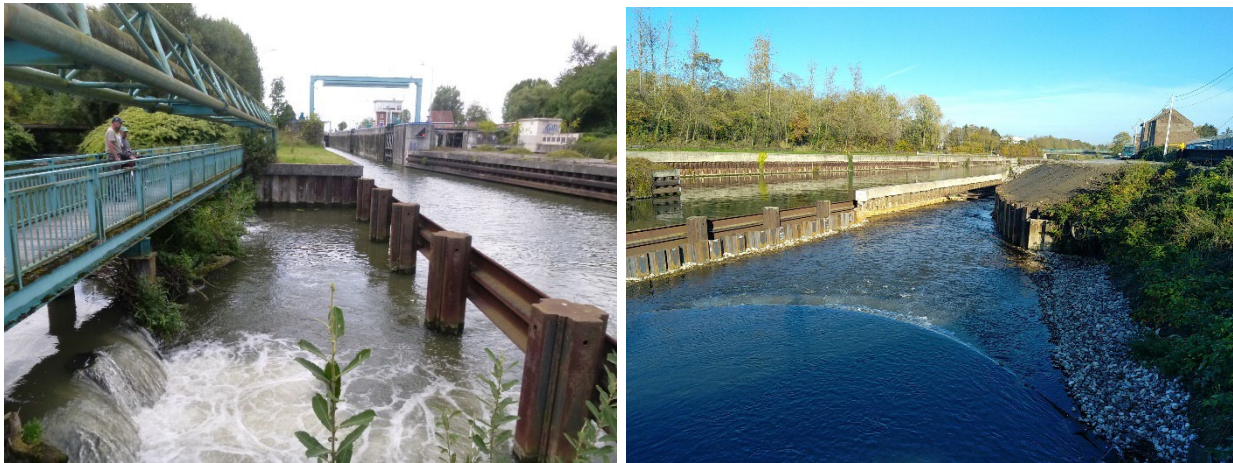
Figure 14 Restauration de la continuité écologique sur l'ouvrage en palplanche à la confluence avec l'Escaut (VNF)
