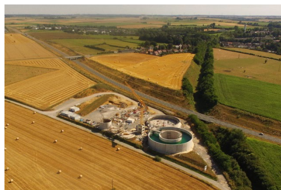
Figure 10 Construction de la nouvelle station d'épuration du Cateau Cambrésis (FDAAPPMA 59)
